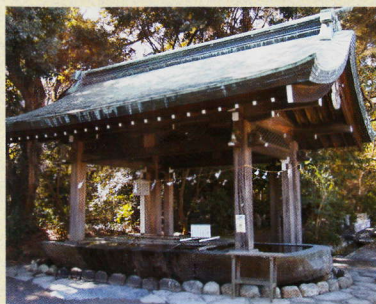
手水舎 (1枚岩をくり貫いたものでは日本一の大きさ)
